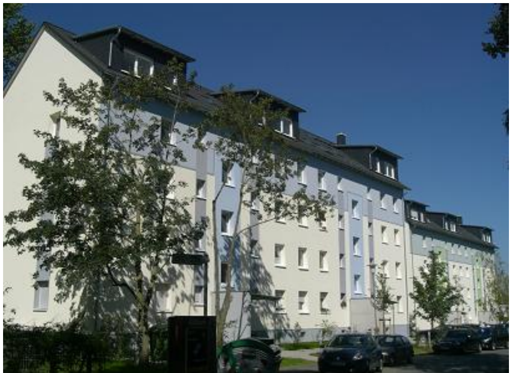
Ansicht vom Schiebelhuthweg nach Modernisierung
