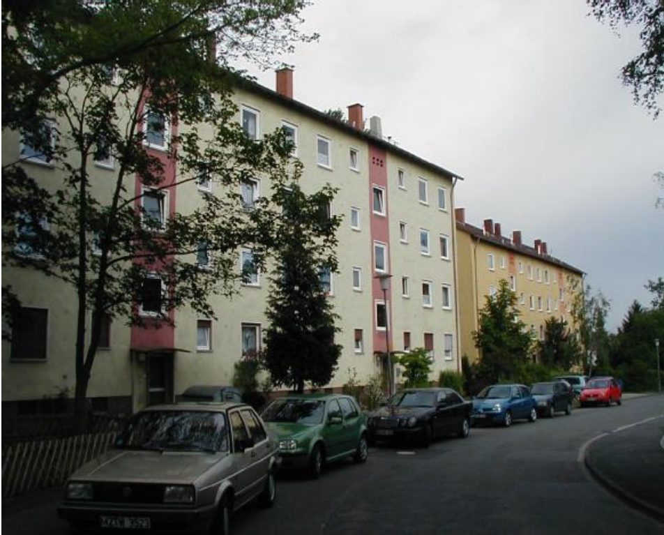
Ansicht vom Schiebelhuthweg vor Modernisierung
