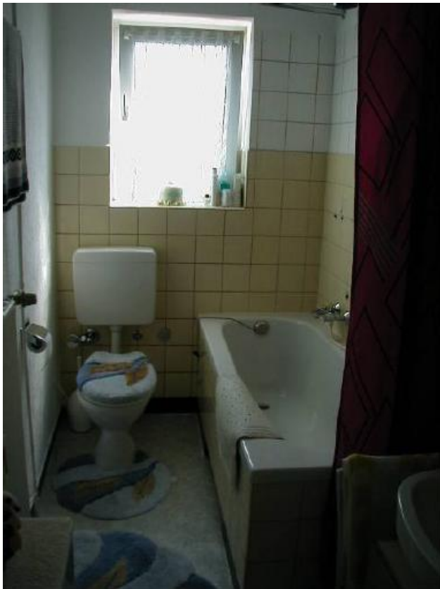
Bestandsbad vor der Sanierung
