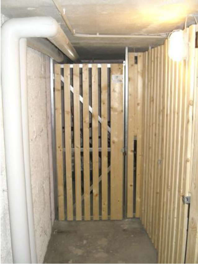
Neue Kellertrennwände
