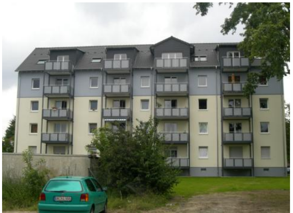
Ansicht vom Haardtring nach Modernisierung
